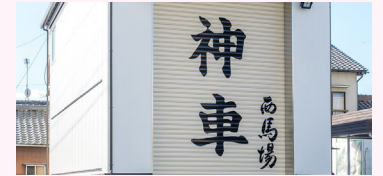
・半田市西地区山車蔵(倉庫)
